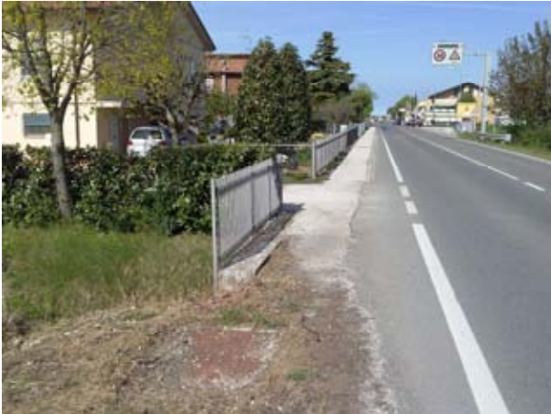
INIZIO CENTRO ABITATO MONTALETTO
